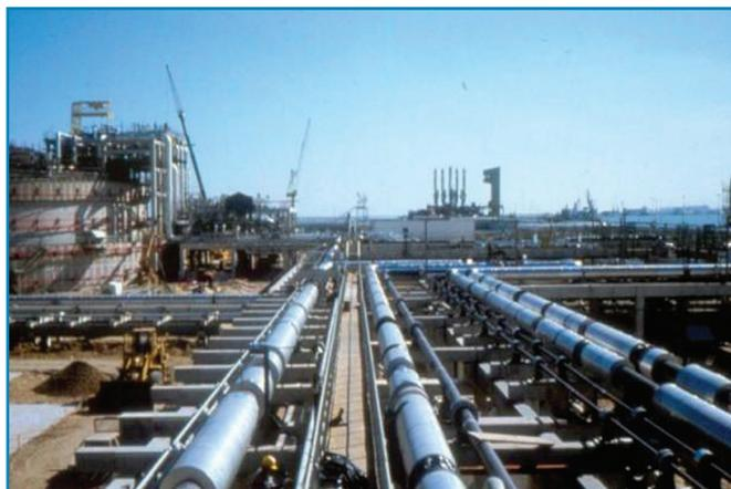
La maggior parte dei sistemi di isolamento utilizzati sono composti da una struttura multistrato di sezioni isolanti, barriere al vapore e giunti d'espansione.
