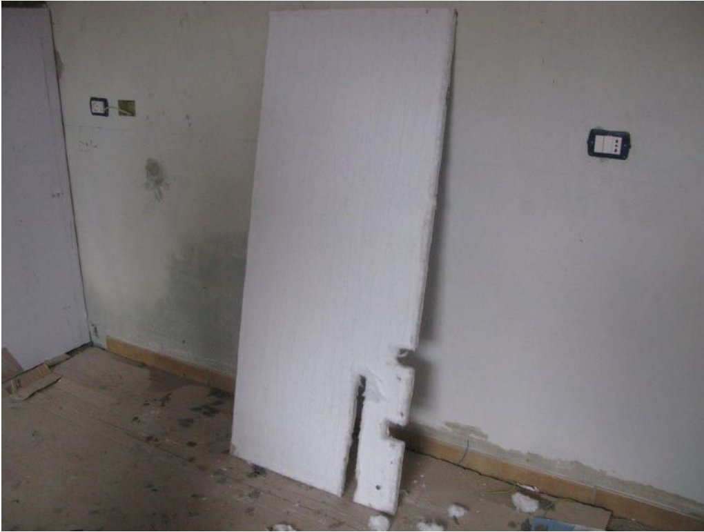
Facile predisposizione di tagli per passaggio impianti
