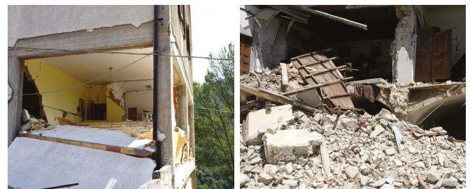
Ribaltamento fuori piano della parete perimetrale esterna - collasso di pareti e volte in muratura
