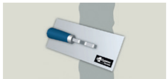
Copertura del nastro d'armatura (2ª mano)
