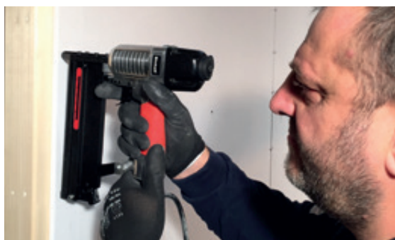
Avvitatura/Graffatura su struttura in legno
