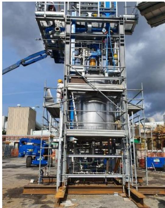
**L'applicazione viene eseguito seguendo le norme di sicurezza per i lavori in quota con gli operatori dotati di sistemi anticaduta , di ponteggi e di piattaforme mobili**
