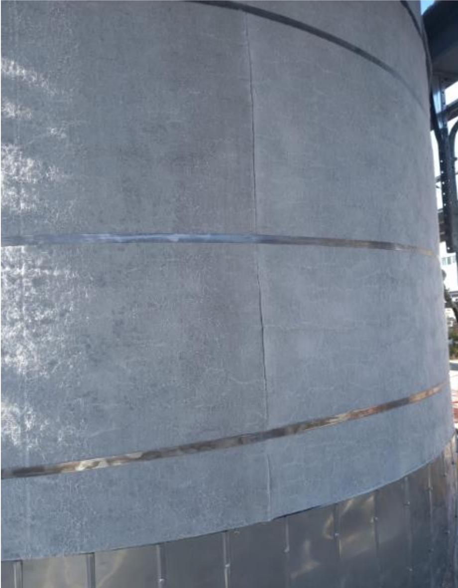
**L'applicazione delle regge in acciaio a stringere , per ogni layer di Pyrogel**
