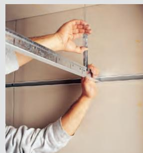
**5** Posizionare il profilo distanziatore da 600 mm ad interasse di 1500 mm, a scatto, nel dorso del profilo primario precedentemente posizionato ad interasse 600 mm. In questo modo si alleghano parallelamente fra di loro tutti i profili primari.
