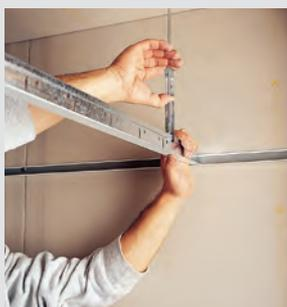
**5** Posizionare i profili secondari da 1200 mm ad interasse di 600 mm, inserendo a scatto le ali, in corrispondenza delle asole riportate sul profilo primario. Inserire successivamente il profilo trasverso da 600 mm, incastrandolo a scatto le ali in corrispondenza delle asole riportate sul profilo secondario da 1200 mm. Si otterranno così i quadrati aventi dimensione 600x600 mm.
