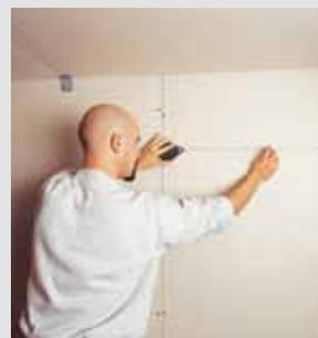
**2** Posizionare il profilo perimetrale in corrispondenza della tracciatura a parete. Marcare sul solaio le linee parallele che individuano la posizione dell'orditura primaria (interasse 60 cm per pannelli in gesso alleggerito e fibre struttura nascosta, interasse 120 cm per pannelli in fibra e Danoline). In corrispondenza delle suddette linee, fissare al solaio i pendini di sostegno ad interasse max di 900 mm.
