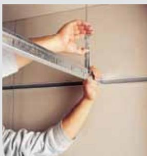
**5** Posizionare i profili secondari da 1200 mm ad interasse di 600 mm, inserendo a scatto le ali, in corrispondenza delle asole riportate sul profilo primario. Inserire successivamente il profilo trasverso da 600 mm, incastrando a scatto le ali in corrispondenza delle asole riportate sul profilo secondario da 1200 mm. Si otterranno così i quadrati aventi dimensione 600x600 mm.
