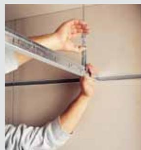
**5** Posizionare il profilo distanziatore da 600 mm ad interasse di 1500 mm, a scatto, nel dorso del profilo primario precedentemente posizionato ad interasse 600 mm. In questo modo si allineano parallelamente fra di loro tutti i profili primari.
