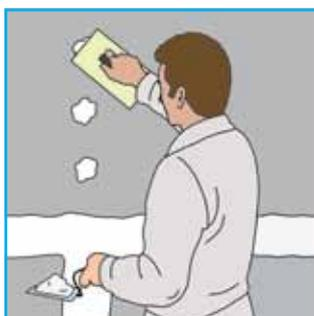
Carteggiare comunque tutte le irregolarità della superficie. Applicare il rasante AQUAPANEL® Q4 Finish su una larghezza di almeno 20 cm (5 cm oltre il bordo del primo strato). Annegare le teste degli elementi di fissaggio e carteggiare le aree irregolari.
