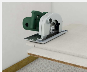
Segare la battentatura sporgente per la posa della prima fila
