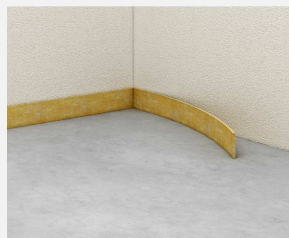
Posare le strisce isolanti perimetrali e unirle testa a testa negli angoli
